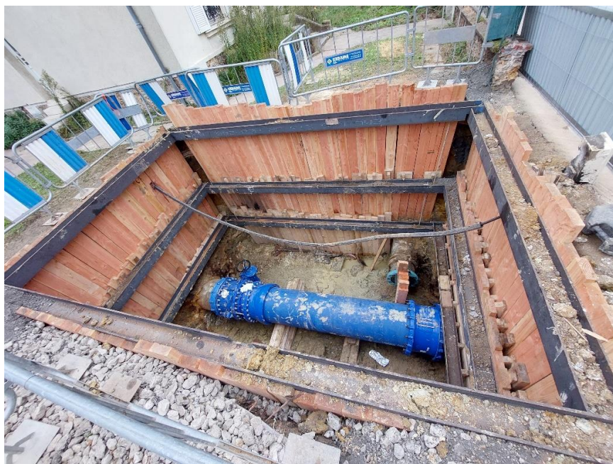
Travaux de renouvellement de la V41 en DN800 Parcelle du 120 Rte des Fusillés de la Résistance – Nanterre
