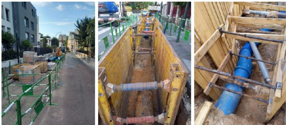
Renouvellement des canalisations DN 400 et DN 600 Rue Auguste Bailly à Asnières-sur-Seine
