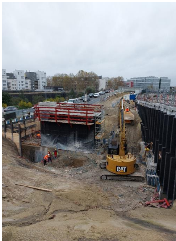
Trémie matériel réhaussée, paroi berlinoise en cours de réalisation, étanchéification des voiles de la galerie en cours
