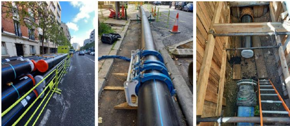
Renouvellement de la canalisation DN 500 Boulevard de la Paix à Suresnes
