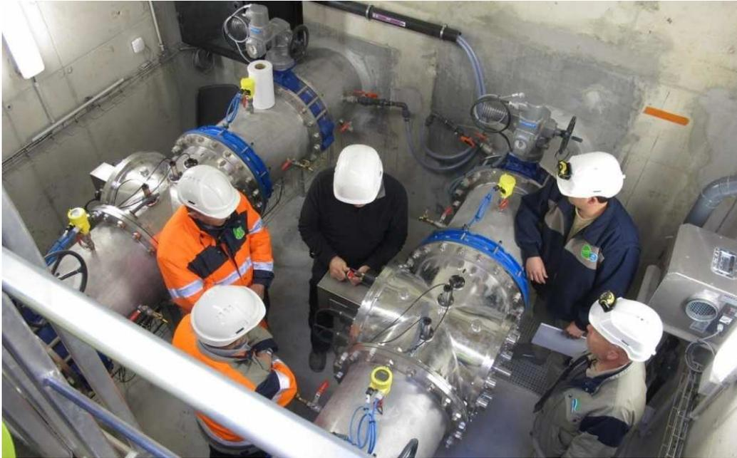
Nanterre, jeudi 3 novembre. Des travaux sont menés sur l'usine de production d'eau, gérée par Eau et Force (Suez) pour le compte du syndicat des eaux de la presqu'île de Gennevilliers, le SEPG. Objectif, une eau débarrassée de micro-organismes et avec moins de calcaire. L'irradiation par UV (photo de la chambre d'irradiation) est une de ces étapes. (LP/O.B.)
