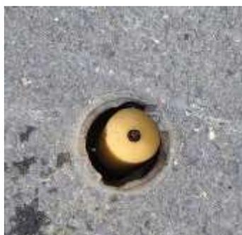
Vue du dessus d'un émetteur et sa protection en mousse dans une bouche à clef
