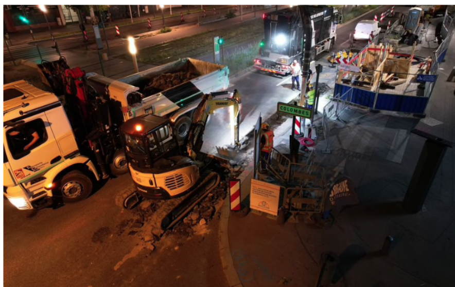
Colombes, le 18 juin. Sénéo, le syndicat producteur et distributeur d'eau potable, mène son chantier de nuit pour limiter les nuisances. LP/O.B.
