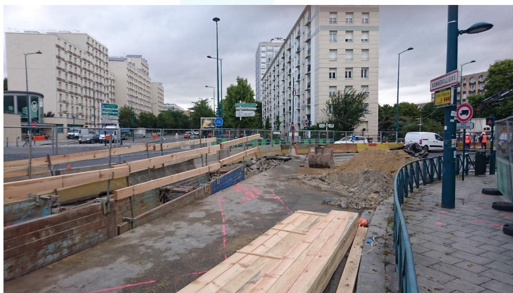
Travaux de renouvellement de canalisations d'eau potable à Gennevilliers
