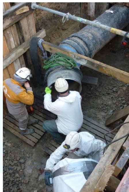
Raccordement de 2 portions de canalisations d'eau potable
