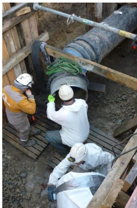
*Raccordement de 2 portions de canalisations d'eau potable*
