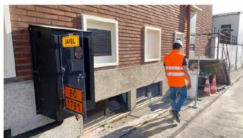
Lors de ces travaux, la capacité de stockage de Javel sur le côté Nanterre de l'usine a été portée à 3 m<sup>3</sup>, contre 1 m<sup>3</sup> précédemment. Un système de remplissage de secours a été aussi mis en place, afin de pouvoir directement livrer de la javel dans cette cuve, au cas où l'alimentation principale (depuis le stockage situé côté Suresnes de l'usine) était interrompue. Une aire de dépotage a été créée afin de permettre cette livraison de secours en toute sécurité.
