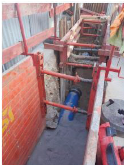
Renouvellement canalisation DN 400 – Carrefour de l'Europe à La-Garenne-Colombes
