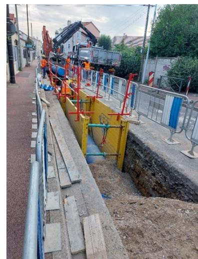
**Travaux de renouvellement de la conduite de la rue des plaideurs à Nanterre – DN600 fonte**
