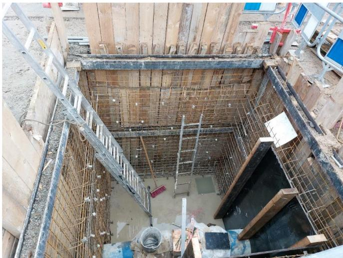
**Travaux en cours de construction de la chambre du débitmètre sur la rue des plaideurs à Nanterre**
